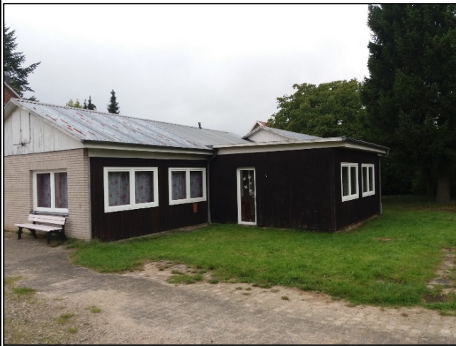
Abbildung 5: Angrenzendes Gebäude im Westen
