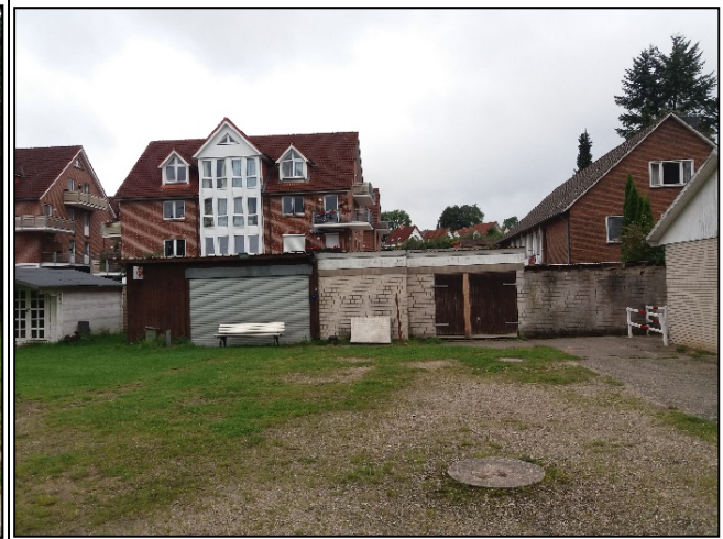
Abbildung 6: Blick nach Westen (div. Nebengebäude)
